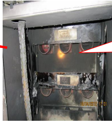
附圖 在開關箱進行 11.4KV 電源對相測試工作時，發生 1 死 5 傷電弧災害
