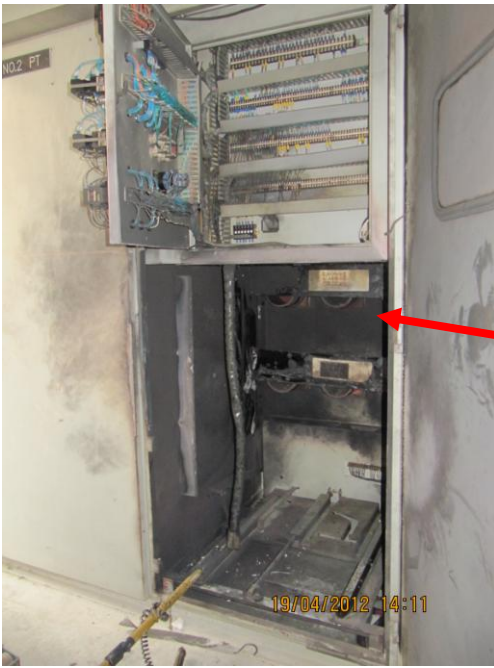
附圖 在開關箱進行 11.4KV 電源對相測試工作時，發生 1 死 5 傷電弧災害
