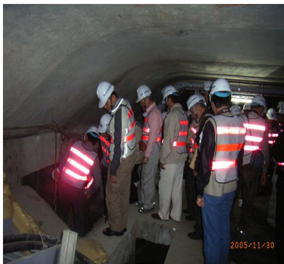
土木工程師與技術員在隧道內進行工程
