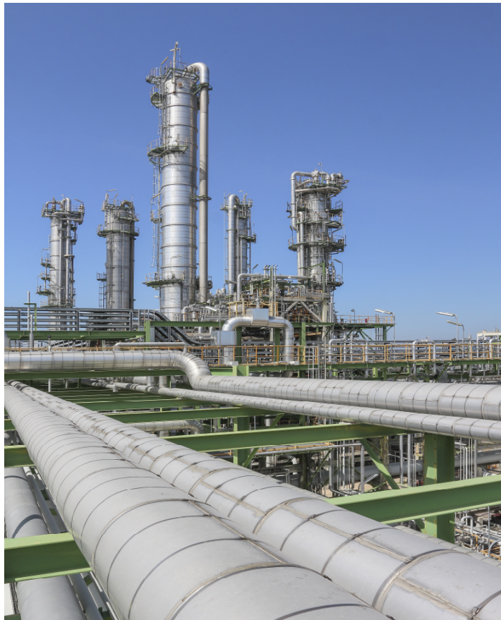
化學材料製造業廠房
