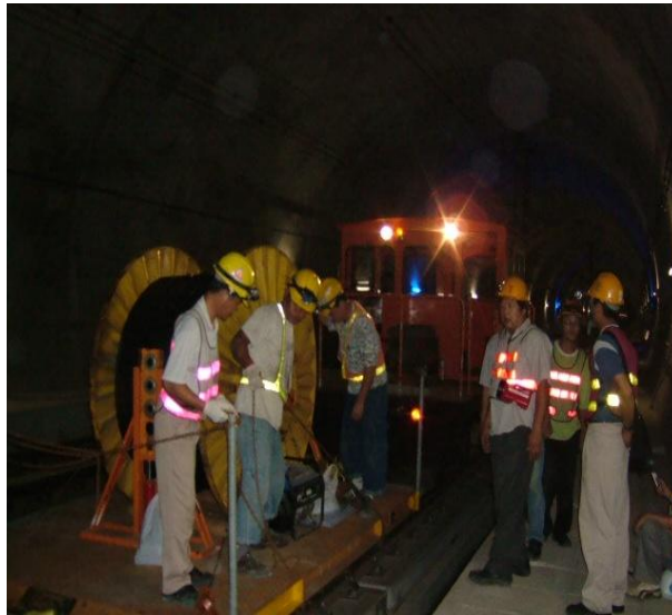
工程人員正進行光纖布纜工程
