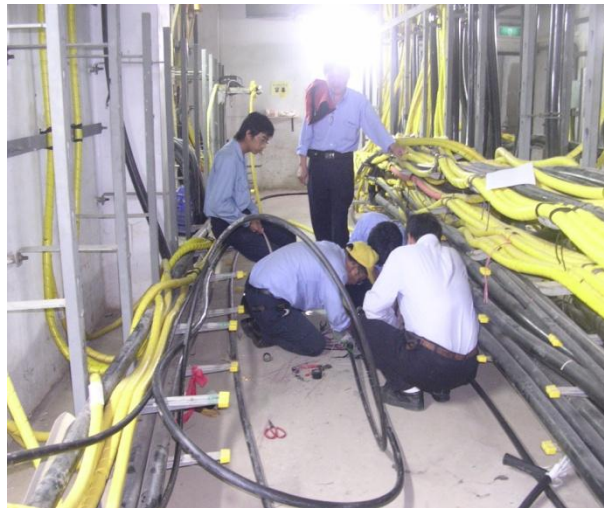
工程人員正在進行線路維修工作
