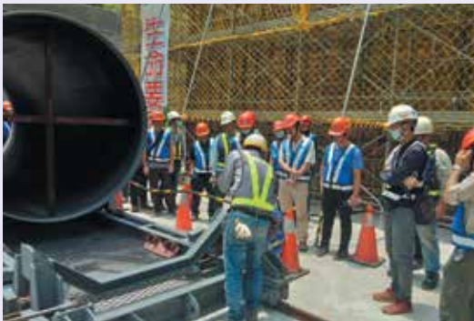
109年8月21日湖山水庫第二原水管工程辦理工程觀摩，輸水路工程鋼管運輸作業解說
