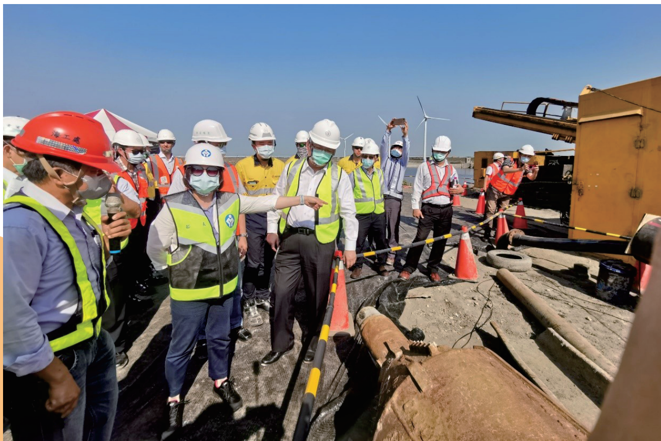
海陸電纜布設施工現場安全設施查察
