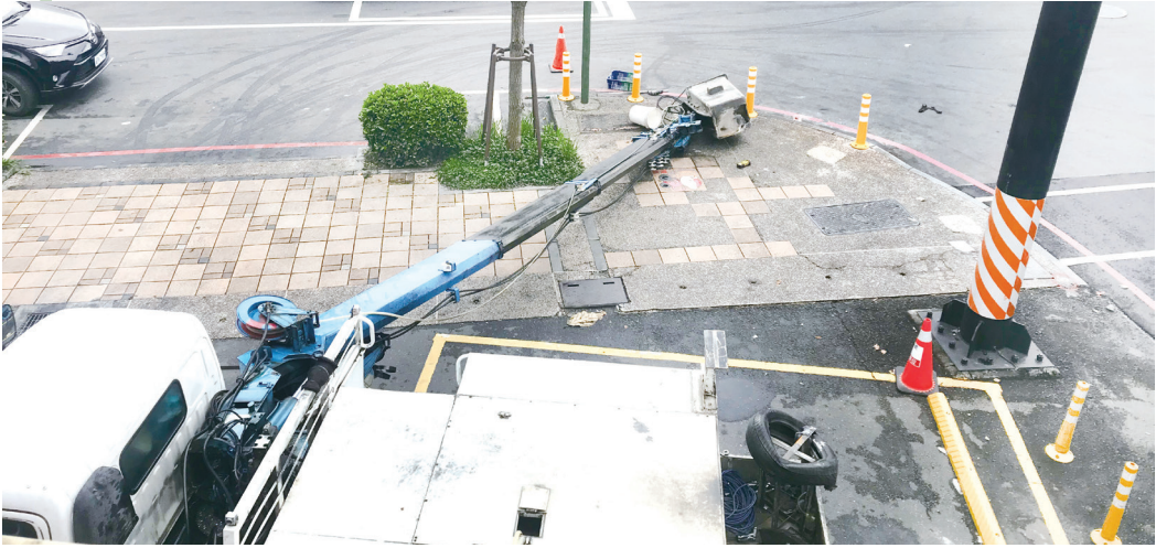
▲ 圖 1 使用高空工作車從事招牌清潔作業，吊桿支撐座螺絲斷裂導致人員隨工作台倒塌，導致作業人員顱內出血死亡
