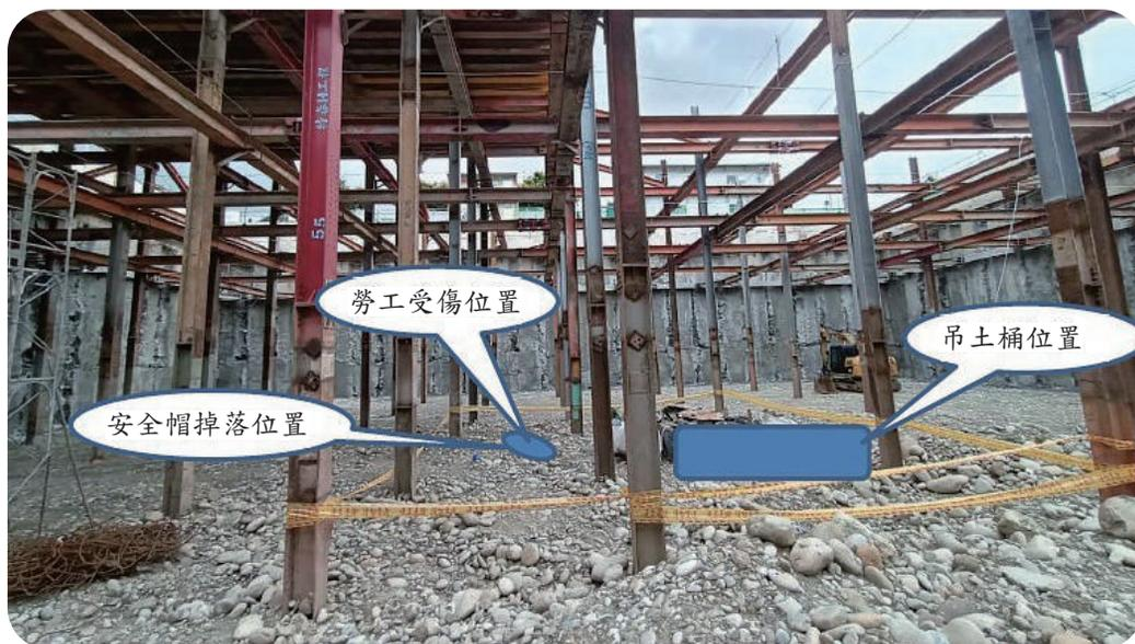
▲ 圖 3：土方吊運作業未採取防止吊掛物通過人員上方及人員進入吊掛物下方之設備或措施肇災
