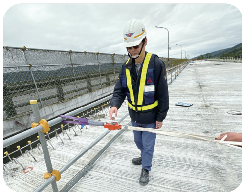
▲ 林銘芳經常親自到工程現場巡查安全設施，確保與當初規劃設置時是一樣的，減少施工時發生意外的可能。
