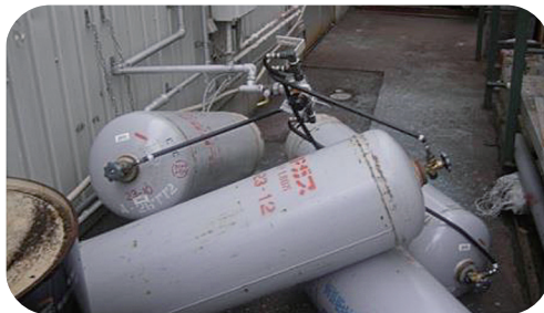
▲ 圖 1：地震後液化石油氣容器傾倒
