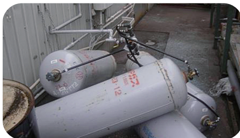
▲ 圖 1：地震後液化石油氣容器傾倒
