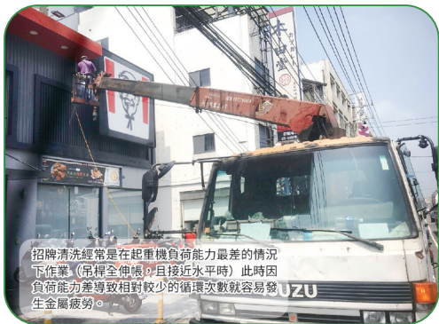
▲ 圖 6 國內常見使用移動式起重機附掛搭乘設備清洗招牌之作業情形
