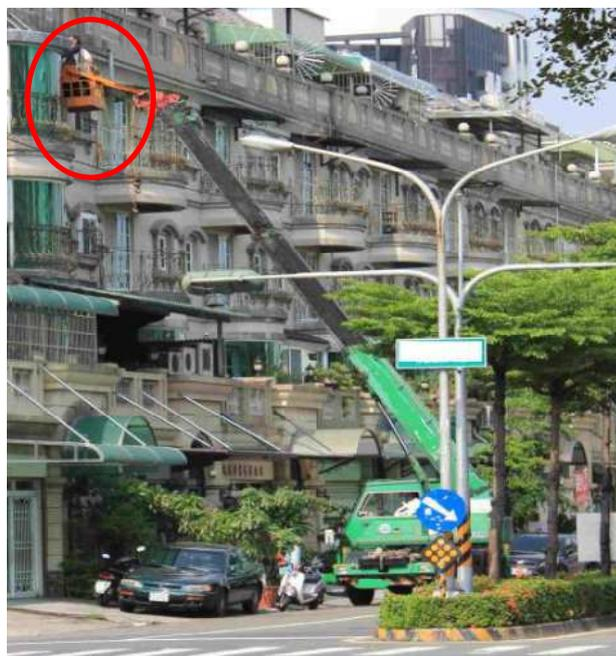
圖 2 以搭乘設備從事外牆作業
