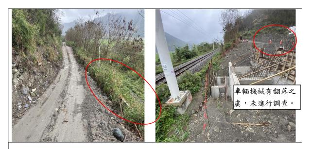
說明:台東縣鹿野里邊坡整治工程對於車輛機械,為避免於作業時發生該機械翻落或表土崩塌等情事,未事先調查該作業場所之天候、地質、地形狀況及所使用車輛機械之種類、性能、行經路線、作業方法。(營造安全衛生設施標準第8-1條)
