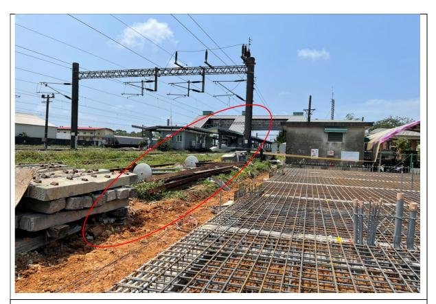
說明:富岡車站旁之工區,臨鐵路軌道側區域未設置適當之固定式圍籬,或未以移動 式圍籬、警告帶圍成之警示區作為設置固定式圍籬有困難時之替代措施。(營造 安全衛生設施標準第8條第1項第1、2款)
