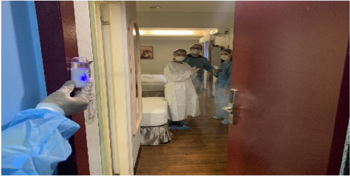
圖 2：本部勞動及職業安全衛生研究所利用簡易煙霧產生裝置協助防疫旅館通風系統檢視
