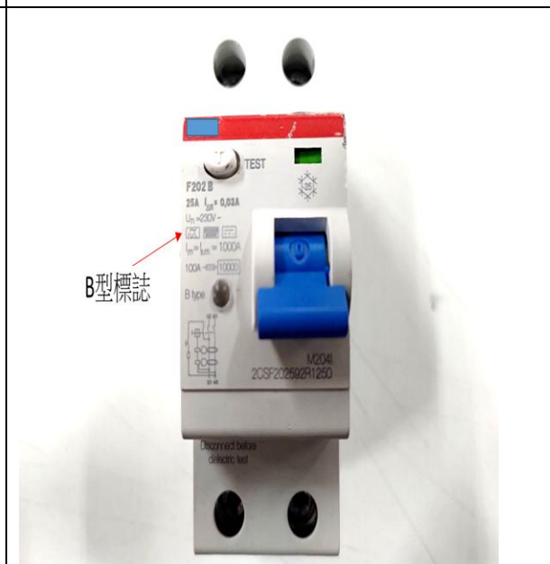
B 型漏電斷路器
