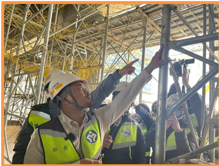
洪申翰部長提醒建築工地使用模板支撐應確實設置插銷。
