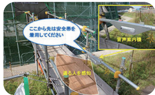
▲ 圖 5：施工架入口紅外線感應式語音提示
