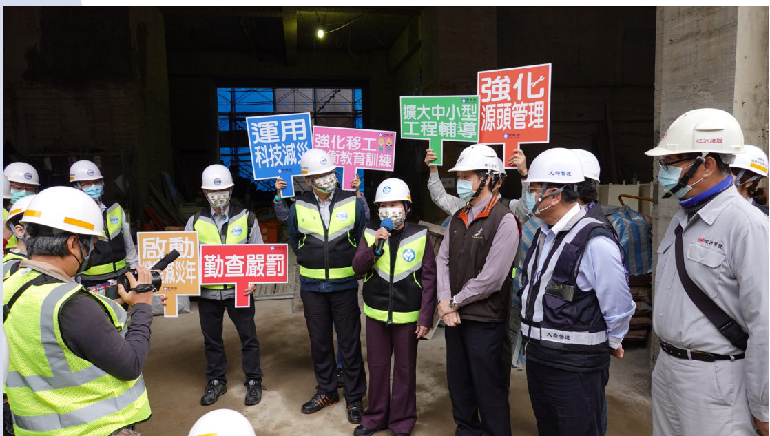
許銘春部長110年第一天上班日，率職安署及會同新北市勞工局對新北市林口區建築投資工程執行勞動檢查，宣示啓動營造業減災加強年
